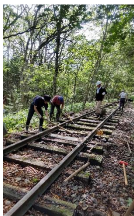
腐食枕木の撤去作業
