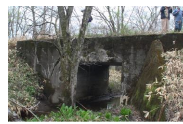
④コンクリート橋
