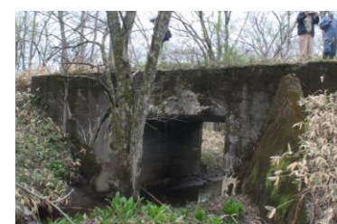
④コンクリート橋
